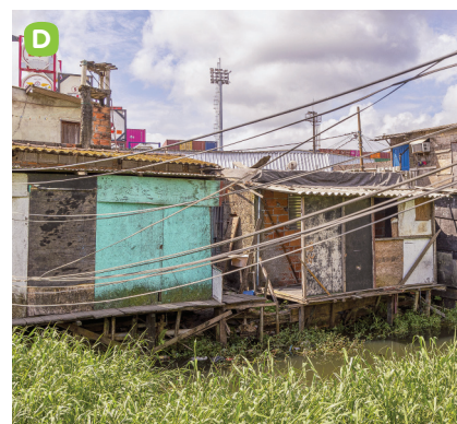
▲ MORADIAS IMPROVISADAS CONSTRUÍDAS COM MADEIRA EM SANTOS, SÃO PAULO. FOTO DE 2025.
