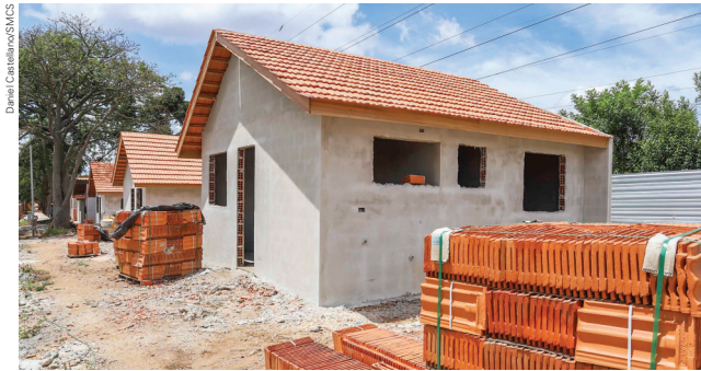
CONSTRUÇÃO DE UM CONJUNTO DE CASAS EM CURITIBA, PARANÁ. FOTO DE 2024.
