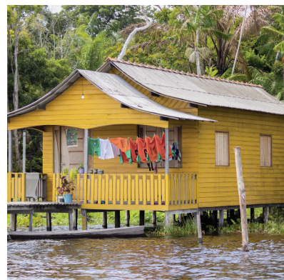
▲ PALAFITA JÁ PRONTA ÀS MARGENS DO RIO ANAPU, EM PORTEL, PARÁ. FOTO DE 2023.
