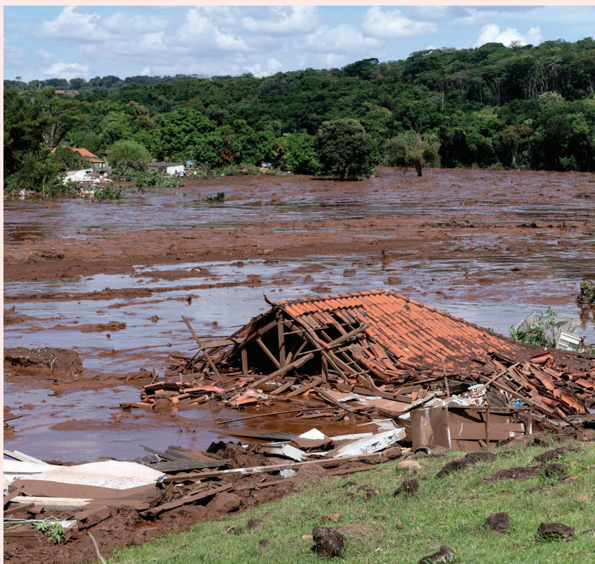
▲ Destruição causada pelo rompimento da barragem de rejeitos no distrito de Brumadinho (MG), em 2019.
