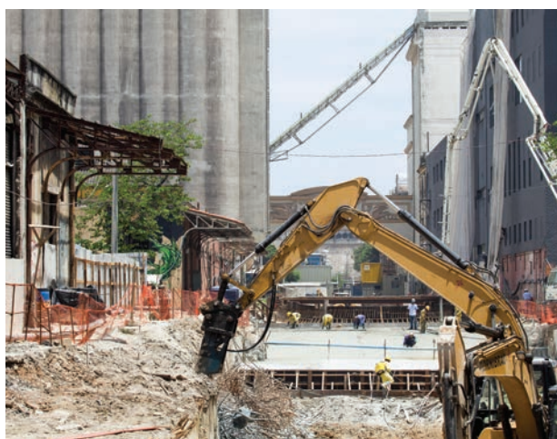
Obras de revitalização do Porto do Rio de Janeiro (RJ). Foto de 2013.
