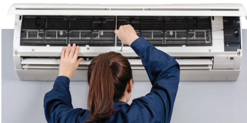
Mulher instalando ar-condicionado.
