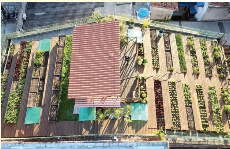
Telhado com horta orgânica em sede da Comunidade dos Pequenos Profetas, organização não governamental no bairro de São José, Centro do Recife (PE). Esse tipo de cobertura garante o isolamento térmico e regula a drenagem de águas. Foto de 2023.
