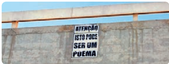
↑ Intervenção do Coletivo Transverso no Buraco do Tatu, trecho que liga os eixos Norte e Sul em Brasília, 2013.
