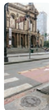
↑ Tampa de galeria de água no centro de São Paulo (SP). Foto de 2022.
