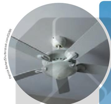
↑ Ventiladores e turbinas eólicas realizam funções inversas: os ventiladores transformam energia elétrica em mecânica e, por isso, são receptores; as turbinas eólicas transformam energia mecânica dos ventos em energia elétrica e, por isso, são consideradas geradores.
