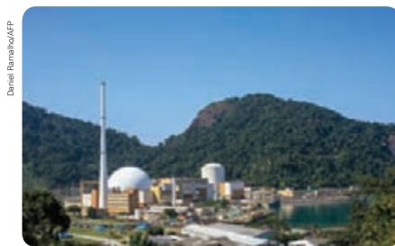
↑ No Brasil, existem duas usinas nucleares em funcionamento na cidade de Angra dos Reis (RJ). Foto de 2016.
